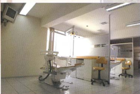
Vista de sillas dentales marca Emedsa instaladas en la Clínica Docente de Miraflores. Cuentan con todo el equipo necesario para brindar una atención y enseñanza de primer nivel.
